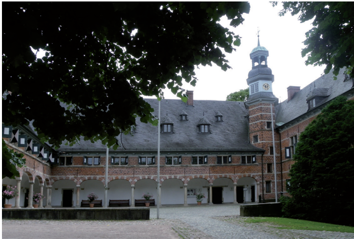
Abb. 3: Schloss Reinbek, Fassaden zum Innen- hof nach der Sanierung und dem Abbruch des Treppenhauses, mit den wieder geöffneten Arkaden (2017) (Foto: Günther Bock)
