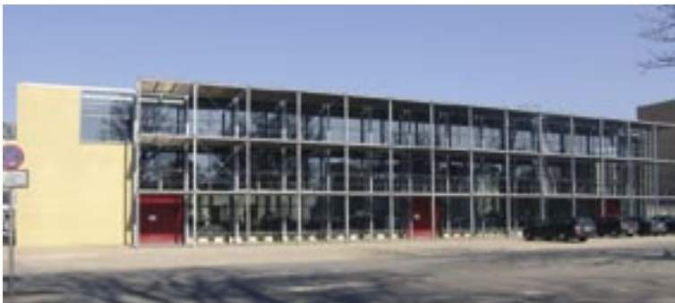
Der Neubau des Museums Tuch + Technik in Neumünster
